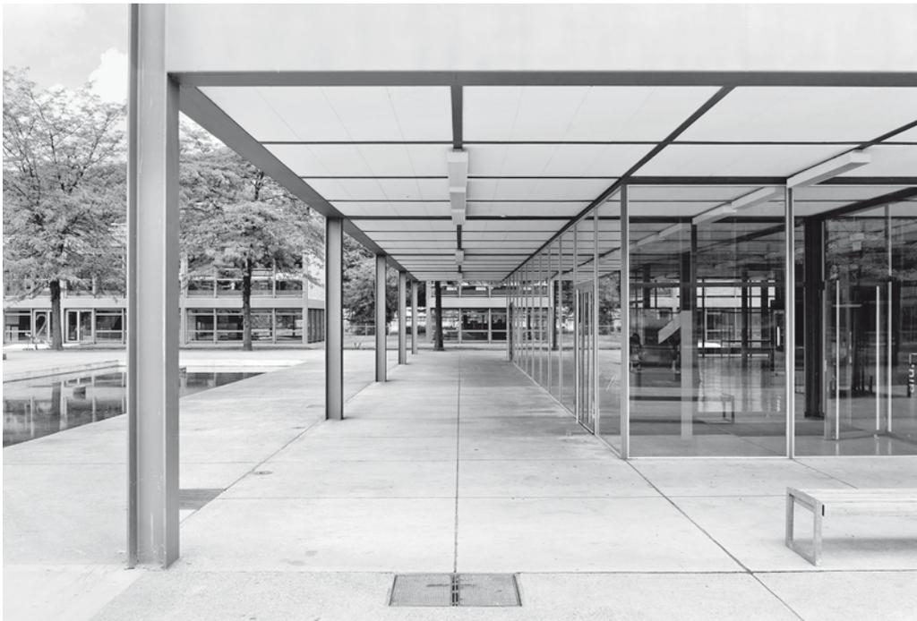
Abb. 21 Omnipräsentes Raster auf Boden- und Deckenplatten, innen und aussen.
