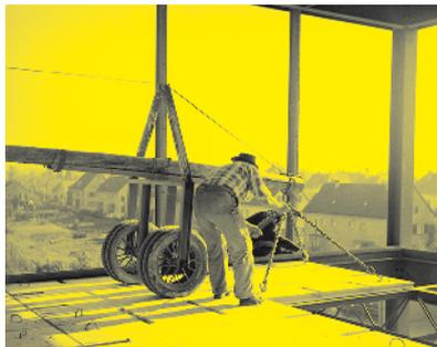
Abb. 19 Ein bisschen wie Lego: Ein Arbeiter setzt die vorfabrizierten Bodenplatten.
