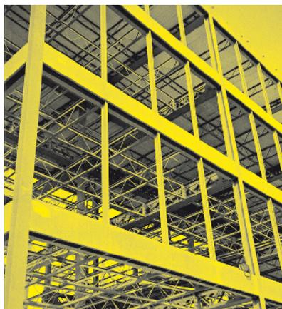
Abb. 16 Das Stahlgerippe des Hauptbaus.
