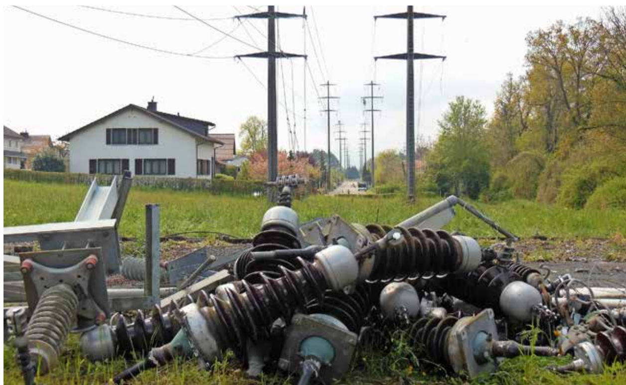
Anfang Mai lagen bereits die Isolatoren vom Abspannbau darnieder. Kurz darauf folgten die Masten.
